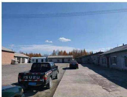
本项目办公室现状照片
