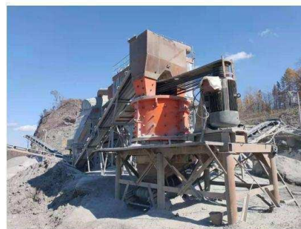
本项目破碎区现状照片
