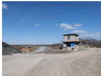
本项目北侧现状照片
