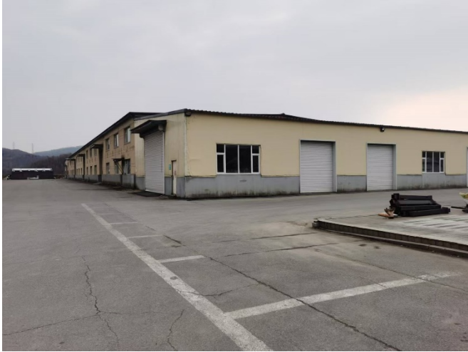
本项目冻干饮片车间（依托现有厂房）
