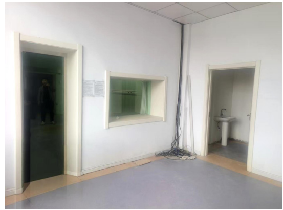
DSA 手术室南侧操作间
