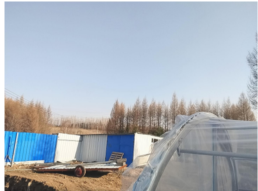
西侧临时板房
