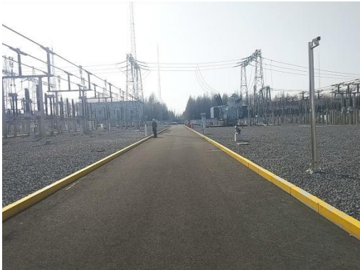
站内道路及碎石场地
