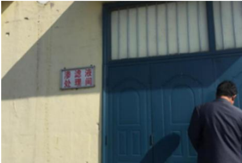
项目渗滤液处理车间
