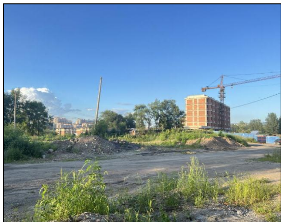
地块东侧空地（待建楼房）
