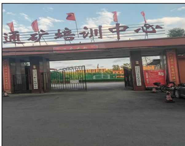
地块北侧通化矿务局职工中等专业学校
