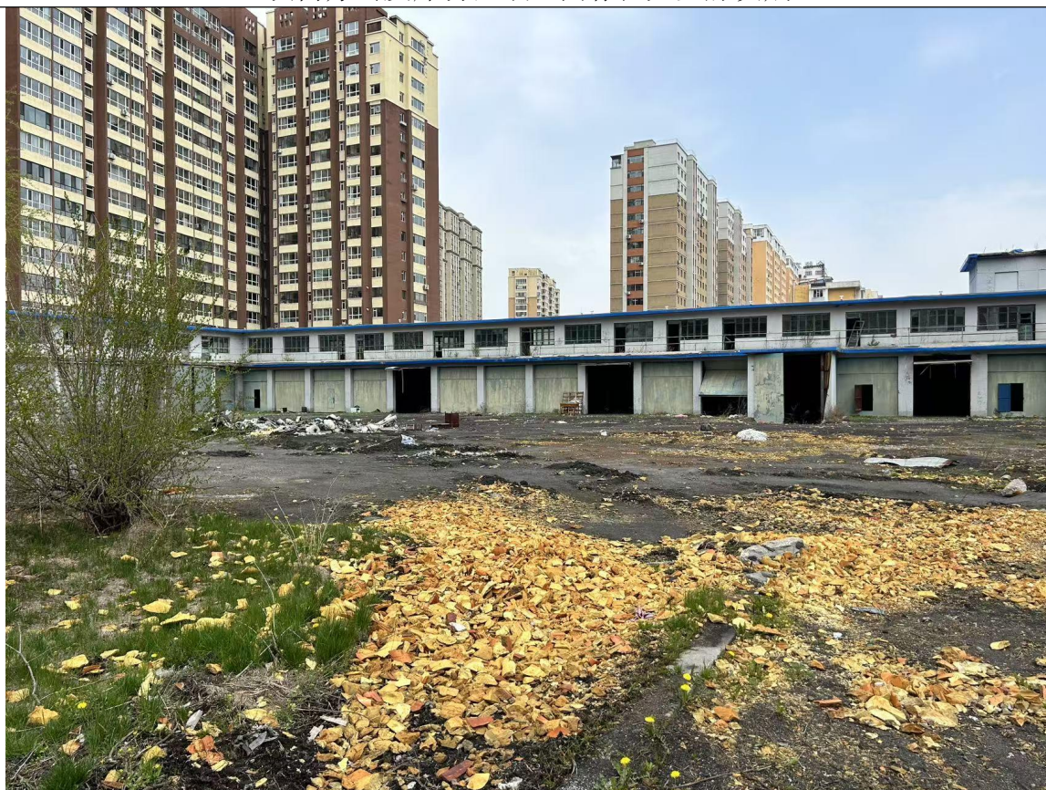
地块内脱硫废水预处理池西北侧存在大量废弃保温材料等建筑垃圾
