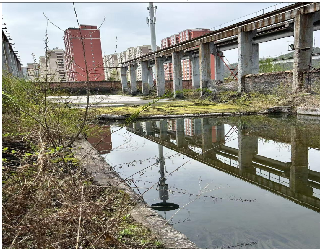
地块内未拆除的脱硫废水预处理池
