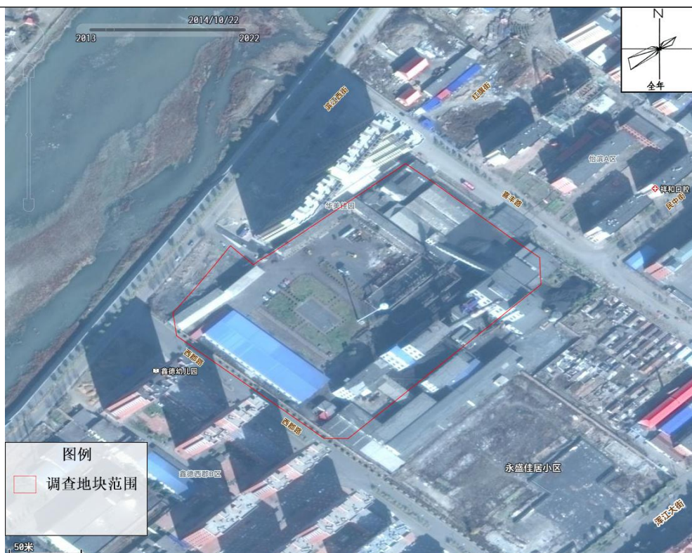
2014年地块历史影像图，地块内为白山市虹桥热力有限公司生产厂区及纸箱厂
