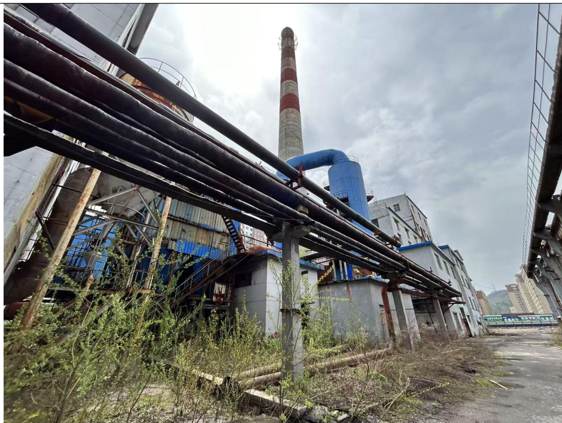
地块内未拆除的生产设备、管道和厂房
